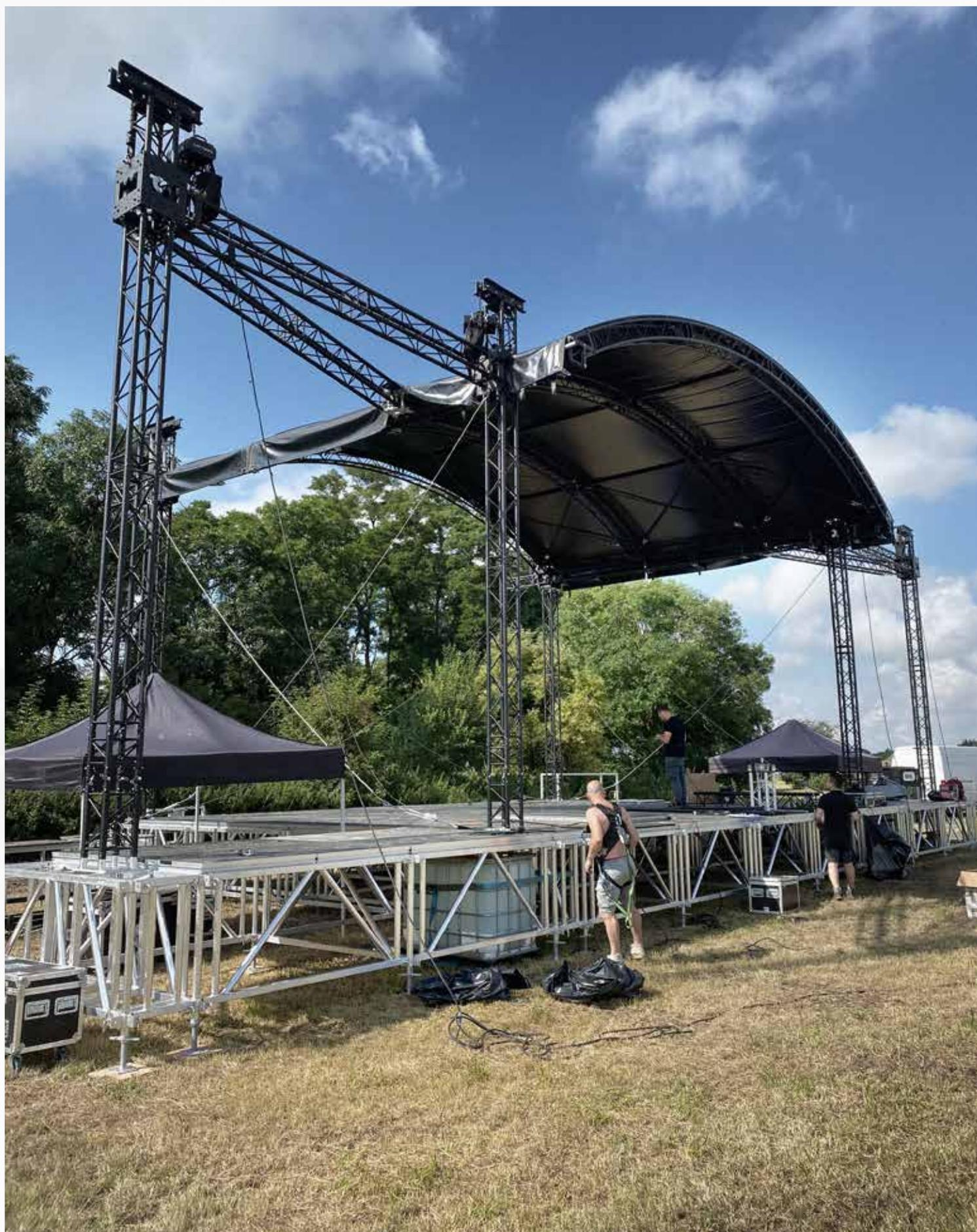
Arc Roof 10 m x 8 m avec ailes de son. Montage sur Subframe82
